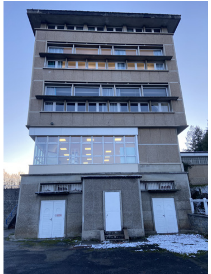
Ancienne entrée de la salle de cinéma
