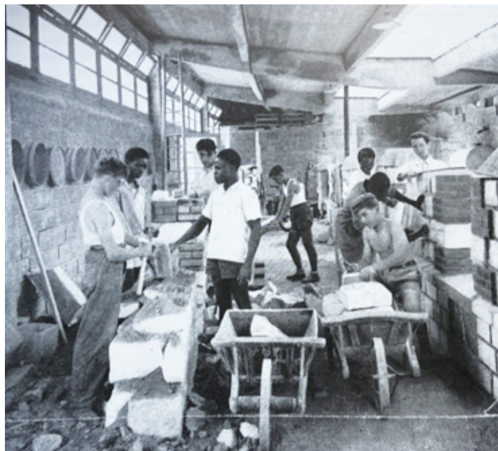
Les maçons dans leurs premiers ateliers couverts d'une dalle de béton armé. Cliché P.Noël
