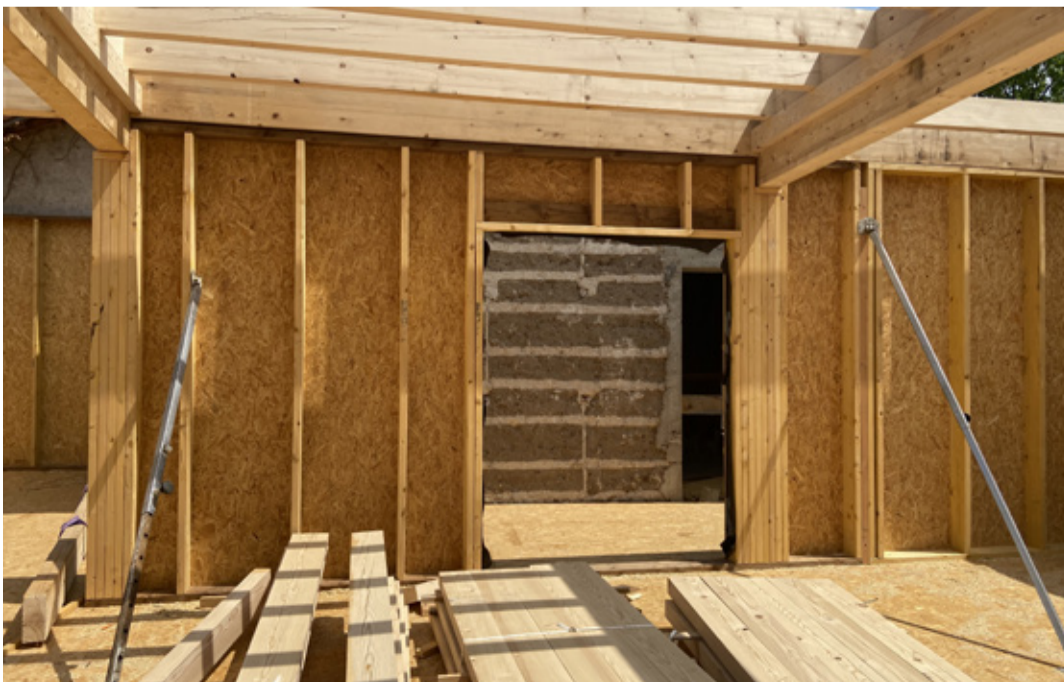
Photo de chantier réalisé pendant mon stage de 5 mois chez Fabriques Architectures Paysages, juin 2022
